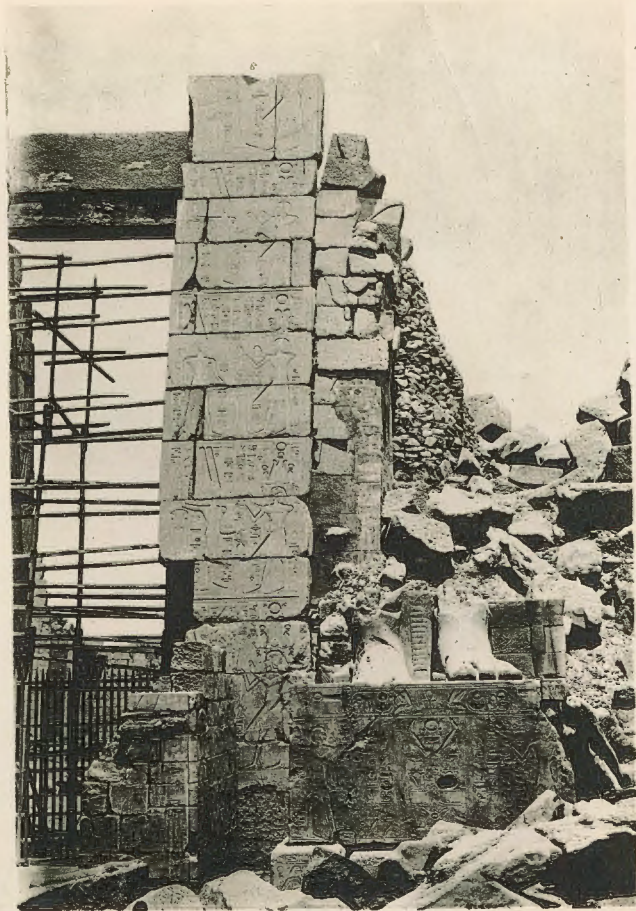
2. — La pile S.-E. est en place et reprise en sous-œuvre, 30 avril 1923.
